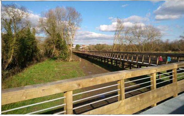
Liaison piétonne et cyclable - Indre
