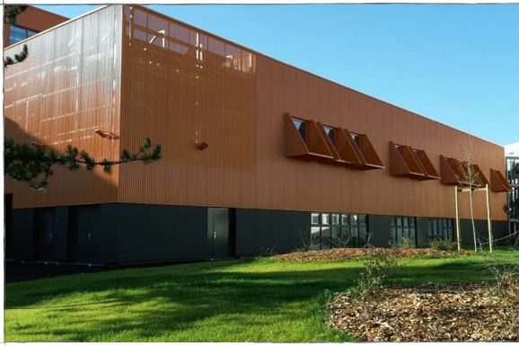
Lycée Monge - Nantes Architecte : Block
