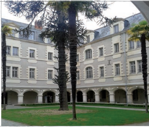
Les Jardins de la Visitation - Nantes Architecte : 2BDM
